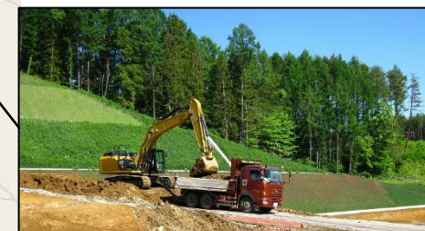
③土砂搬出現場
