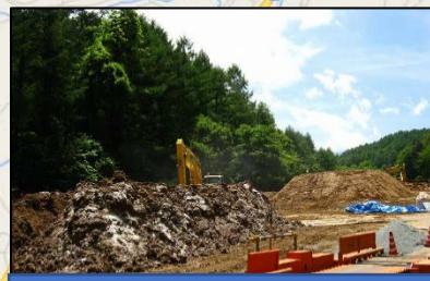
③土砂搬入現場
