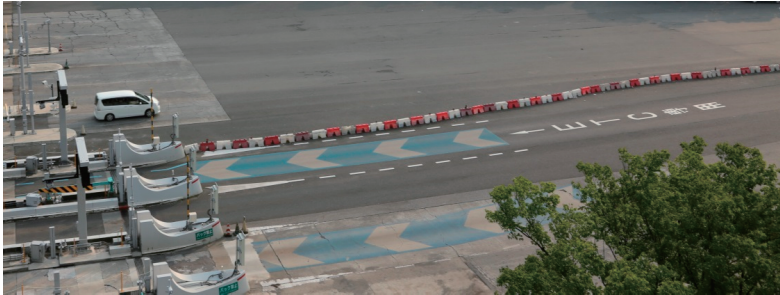
ETCレーンへの路面の誘導標示例
