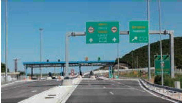
ギリシャの高速道路料金所
