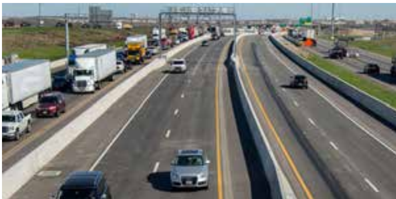
車線管理 (左：通常レーン、右：Toll Managed Lane)
