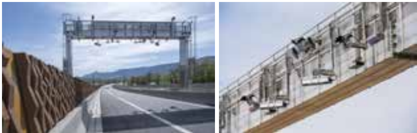
A79のフリーフローETCの外観（左）とガントリーに設置された機器（右）
